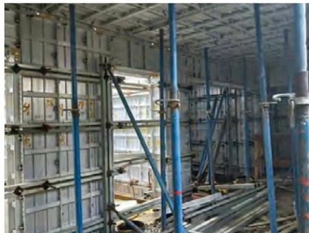
施工現場拼裝可重複利用的建築構件
