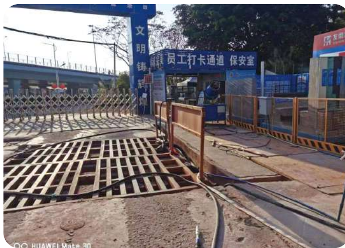
工地出入口實名制管控
