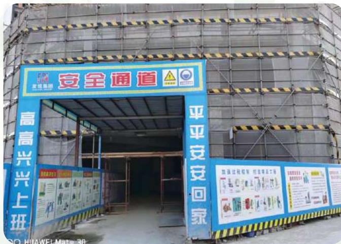
施工安全通道
