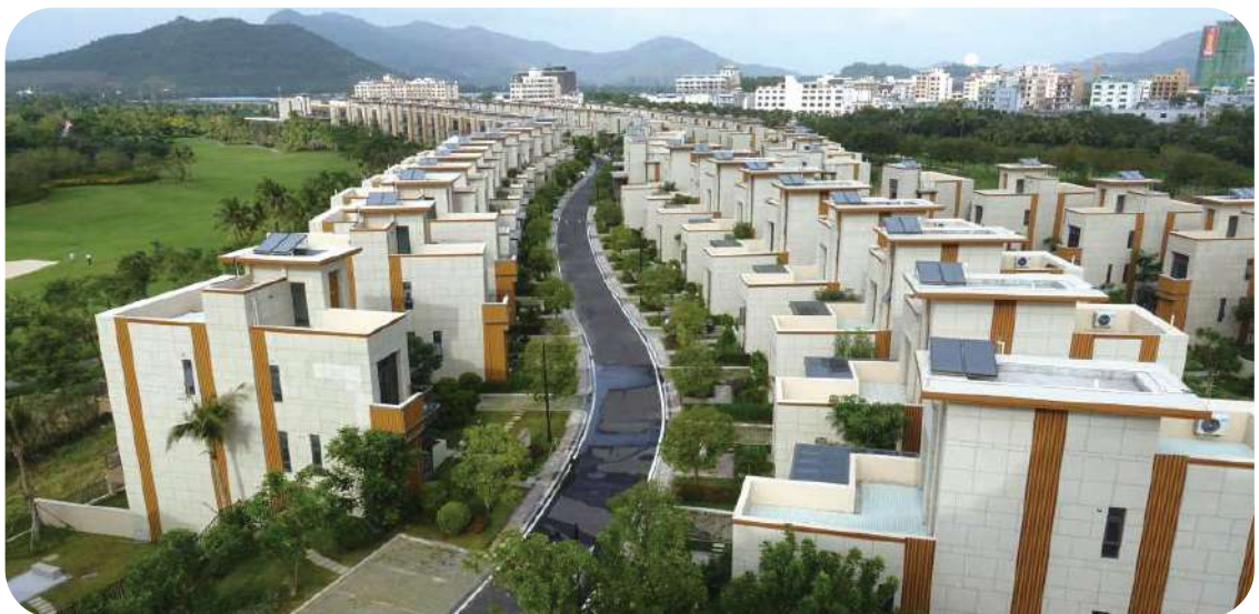
海南清水灣3號安裝太陽能系統
