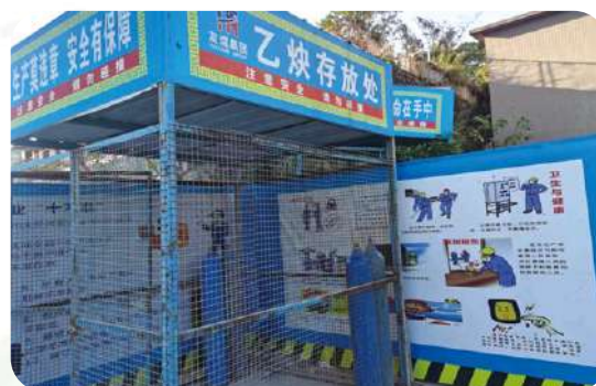
易燃、可燃材料堆放區域
