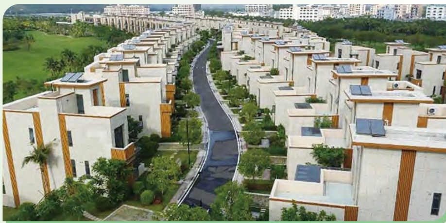
海南清水灣3號安裝太陽能系統
