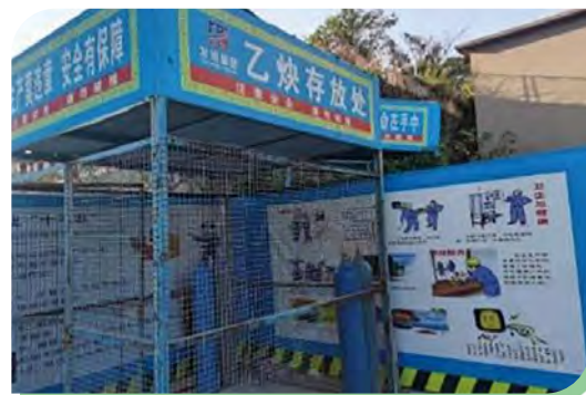
易燃、可燃材料堆放區域
