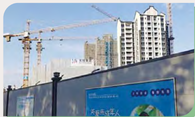
工地降塵噴淋設施
