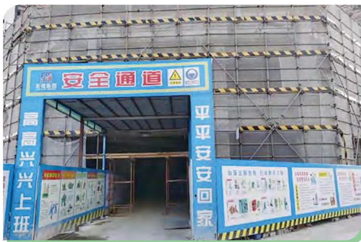
施工安全通道
