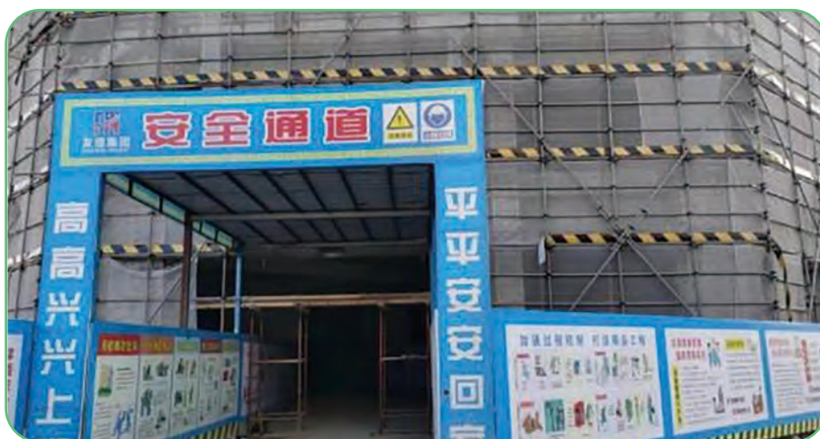
施工安全通道
