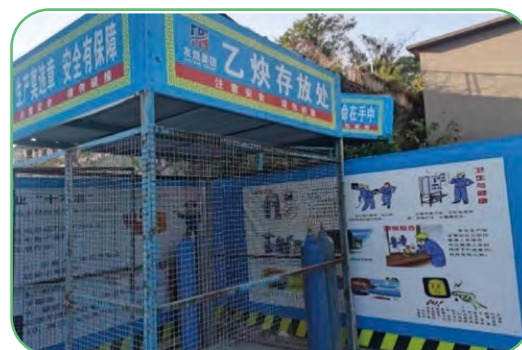
易燃、可燃材料堆放區域
