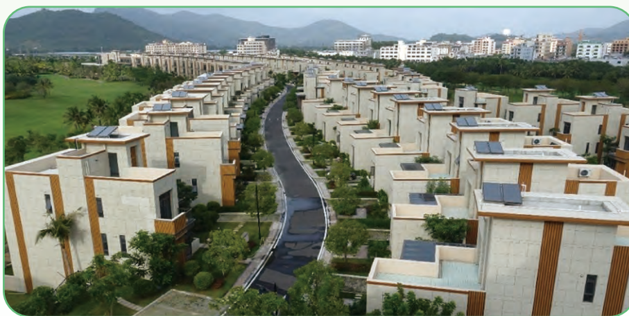
海南清水灣3號安裝太陽能系統
