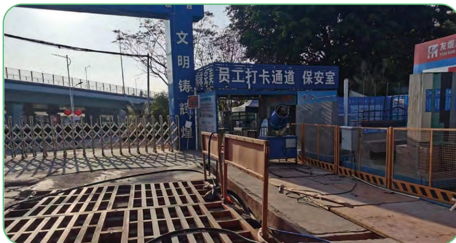
工地出入口實名制管控
